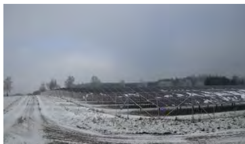
Abb. 073: Freiflächen-PV-Anlage im Nordosten
