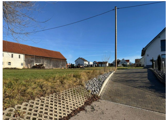
Abbildung 3 - Aufnahme vom 09.12.2025 Blick auf die Zufahrt Pfarrer-Rost-Straße auf Fl.Nrn. 720 und 722 (ehemaligen Hofstelle Fl.Nr. 720 zwischenzeitlich abgerissen)
