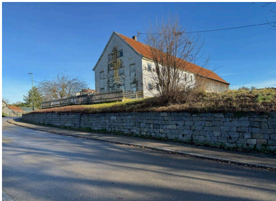
Abbildung 2 - Aufnahme vom 09.12.2025 Blick von der Pfarrer-Rost-Straße auf Stützmauer und Wohngebäude der ehemaligen Hofstelle Fl.Nr. 720 (zwischenzeitlich abgerissen)
