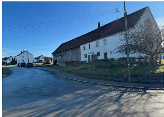
Abbildung 5 - Aufnahme vom 09.12.2025 Blick von der Pfarrer-Rost-Straße in die Kellerbergstraße auf die ehemalige Hofstelle Fl.Nr. 720 (zwischenzeitlich abgerissen)
