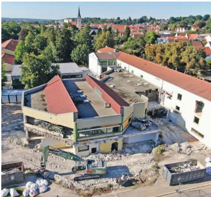
Derteilweise Abriss der Thannhäuser Realschule hat begonnen. Der ursprüngliche Bau aus dem Jahr 1965 (rechts im Bild) kann noch saniert werden. Der achteckige Anbau aus dem Jahr 1976 ist nicht mehr sanierungsfähig und wird komplett abgerissen, weil er in den letzten Jahren große Probleme mit Wassereintritten, herab-
